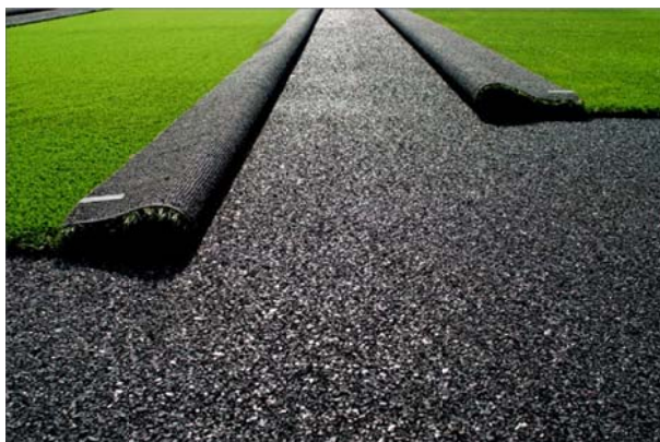
La pose du gazon artificiel à Bürglen dans le canton de Thurgovie.
