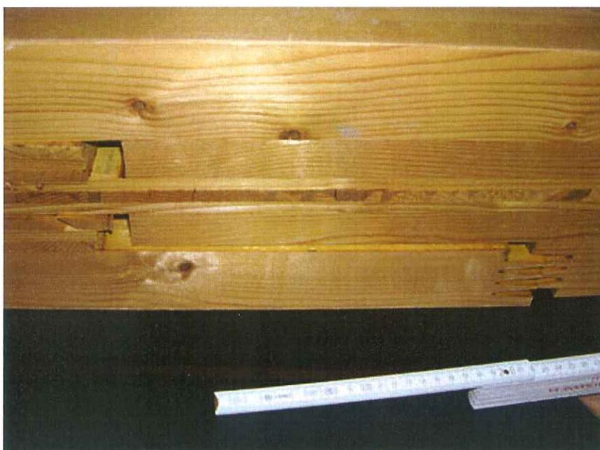
Photo N° 14 : Membrane inférieure rompue
