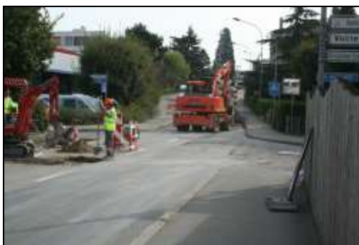
Réfection du revêtement de la route de Crochy
