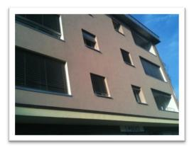
Le changement complet des portes et fenêtres du bâtiment par du matériel moderne à triple vitrage, avec ventilation intégrée au cadre, a supprimé les bruits extérieurs dans les appartements et permet une meilleure aération des locaux et donc une amélioration du rendement du chauffage.
