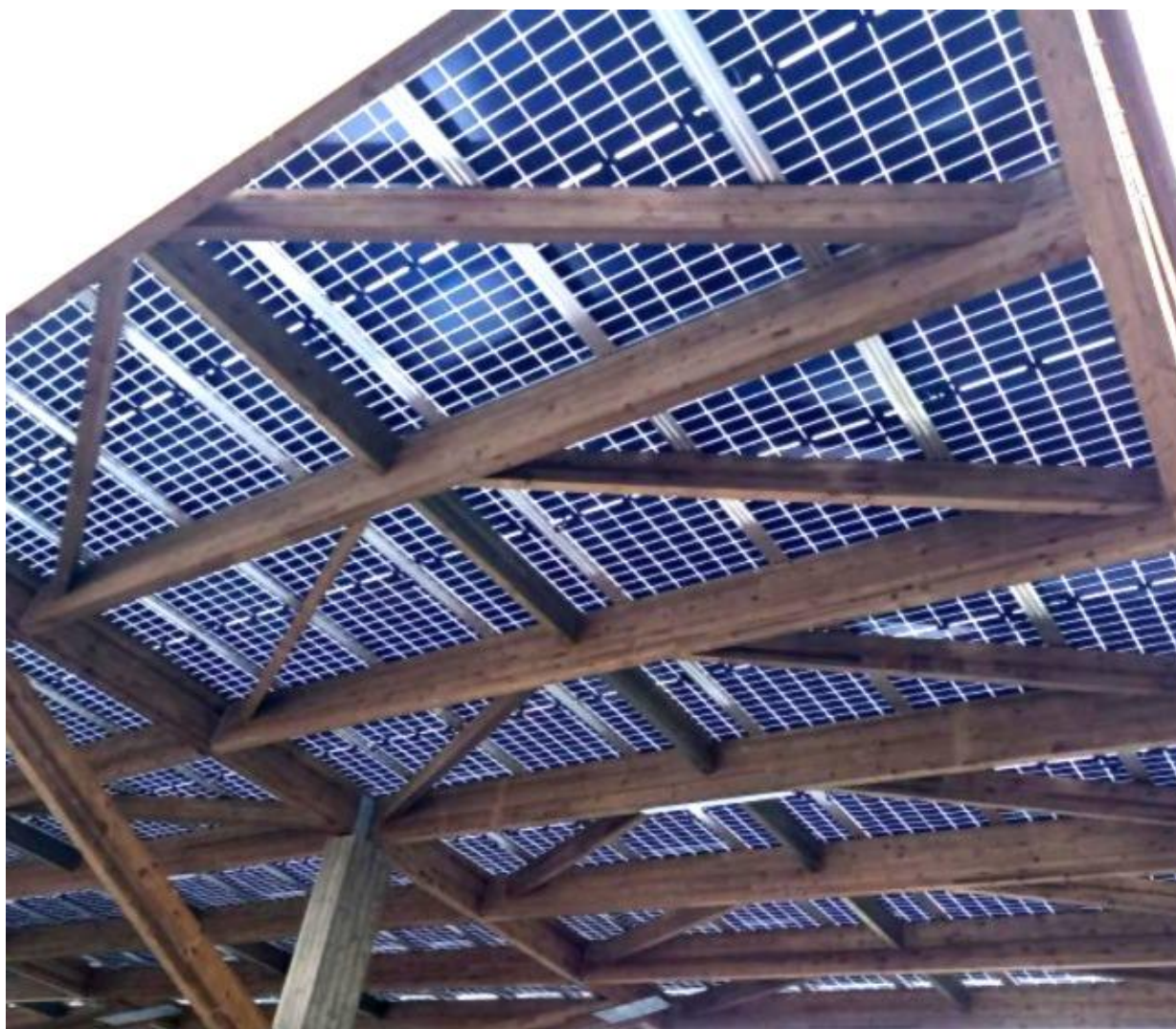
Photo, de panneaux photovoltaïques semi translucides similaires à ceux prévus en toiture du couvert projeté
