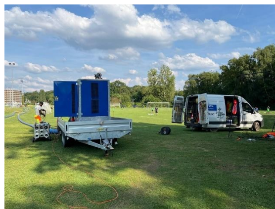
Chemisage secteur 15 – Pompage provisoire
