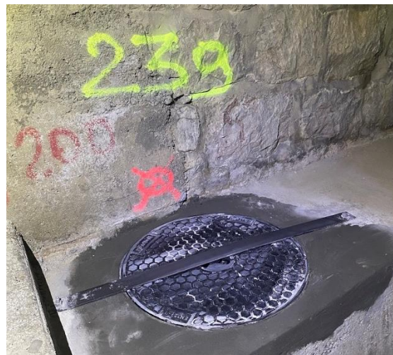
Voûtage Mèbre – Remplacement du couvercle et pose de barrettes en inox
