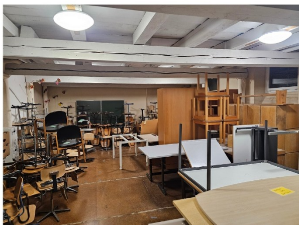
Sous-sol - ancienne garderie « Les Moufflets »
