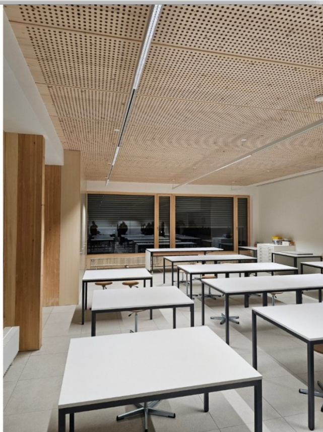
Au plafond, des panneaux acoustiques phonoabsorbants en bois.
