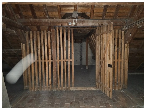
Combles du bâtiment Neptune
