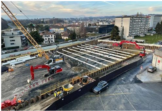
Avenue du Tir-Fédéral 44 - Construction d'un bâtiment administratif et industriel
