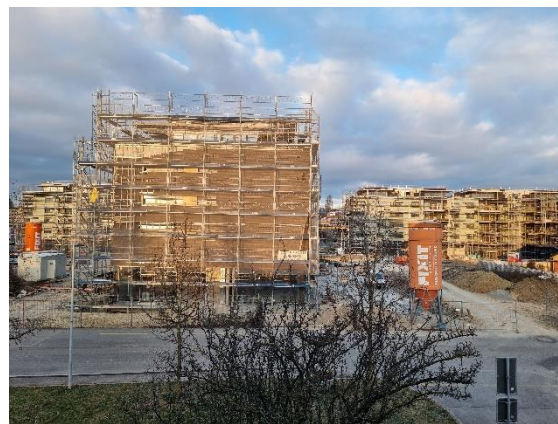
En Mapraz – Construction de 5 immeubles de logements et d'activités secondaires et tertiaires avec un parc paysager, parking souterrain et station transformatrice
