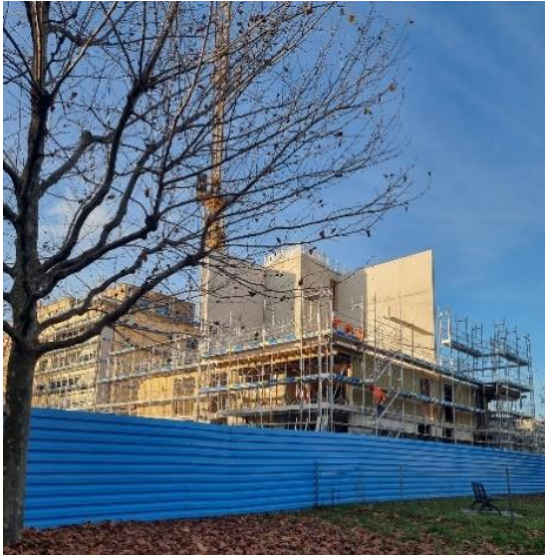
Route du Bois 8 – Rénovation de l'enveloppe du bâtiment avec surélévation et construction d'un nouvel immeuble avec parking souterrain
