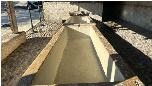
Etanchéité des bassins de la fontaine de Bassenges
