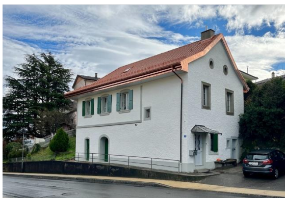
Bâtiment de la rue du Villars 13
