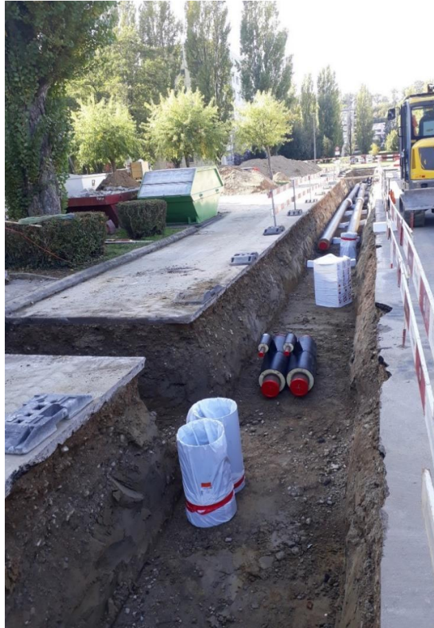
Pose d'une conduite CAD sur une parcelle privée à la route du Bois en 2019.
