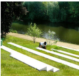
Dalle et escalier en béton
