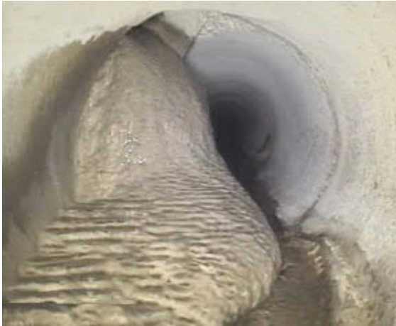
Avant fraisage, calcaire
