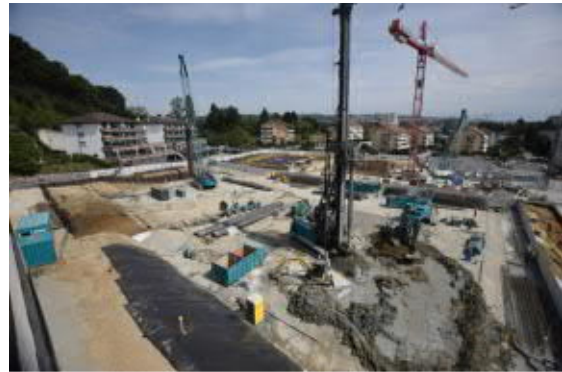
Exécution des pieux de fondation du bâtiment et du rideau de palplanches – août 2017.
