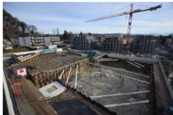
Mise en place des étais et fouille de la salle de gymnastique – décembre 2017.
