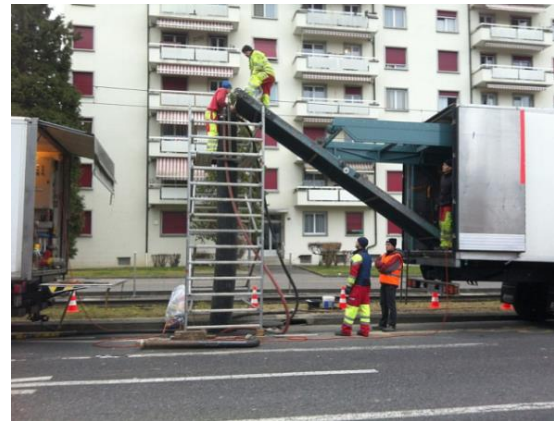
Installation technique pour le gainage du collecteur
