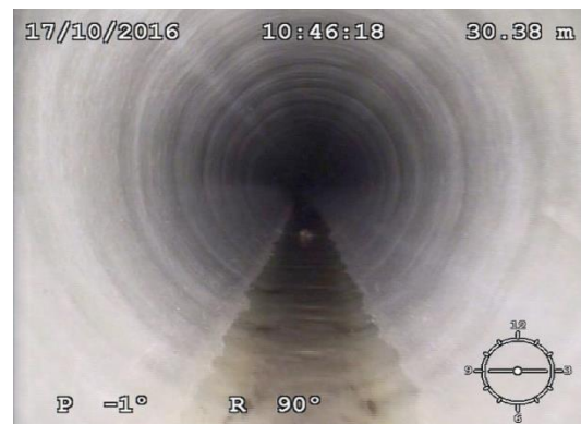
Collecteur après gainage
