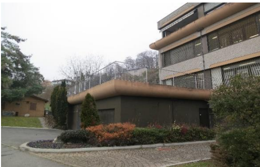
Croset – Nouveau garde-corps – Muret de jardin
