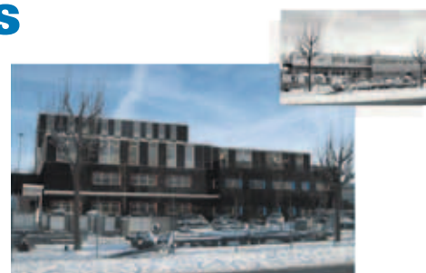
Photomontage du nouveau siège du SIE, avec la vue actuelle du centre d'exploitation
