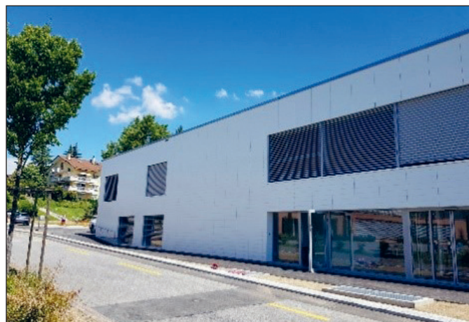
Nouvelle garderie des Pâquis à Saint-Sulpice.
