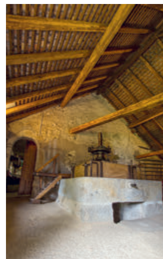
Hangar du Four.
