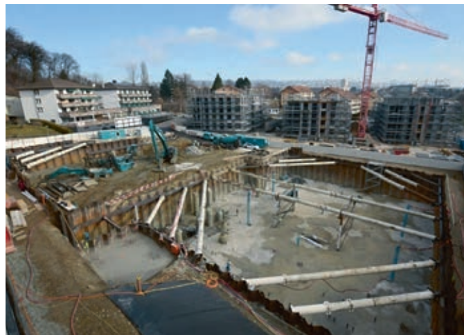
Photo du chantier au 7 décembre 2017.
