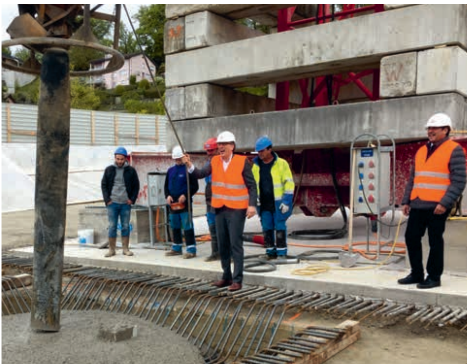
Croset-Parc : la construction d'un nouveau quartier a démarré
