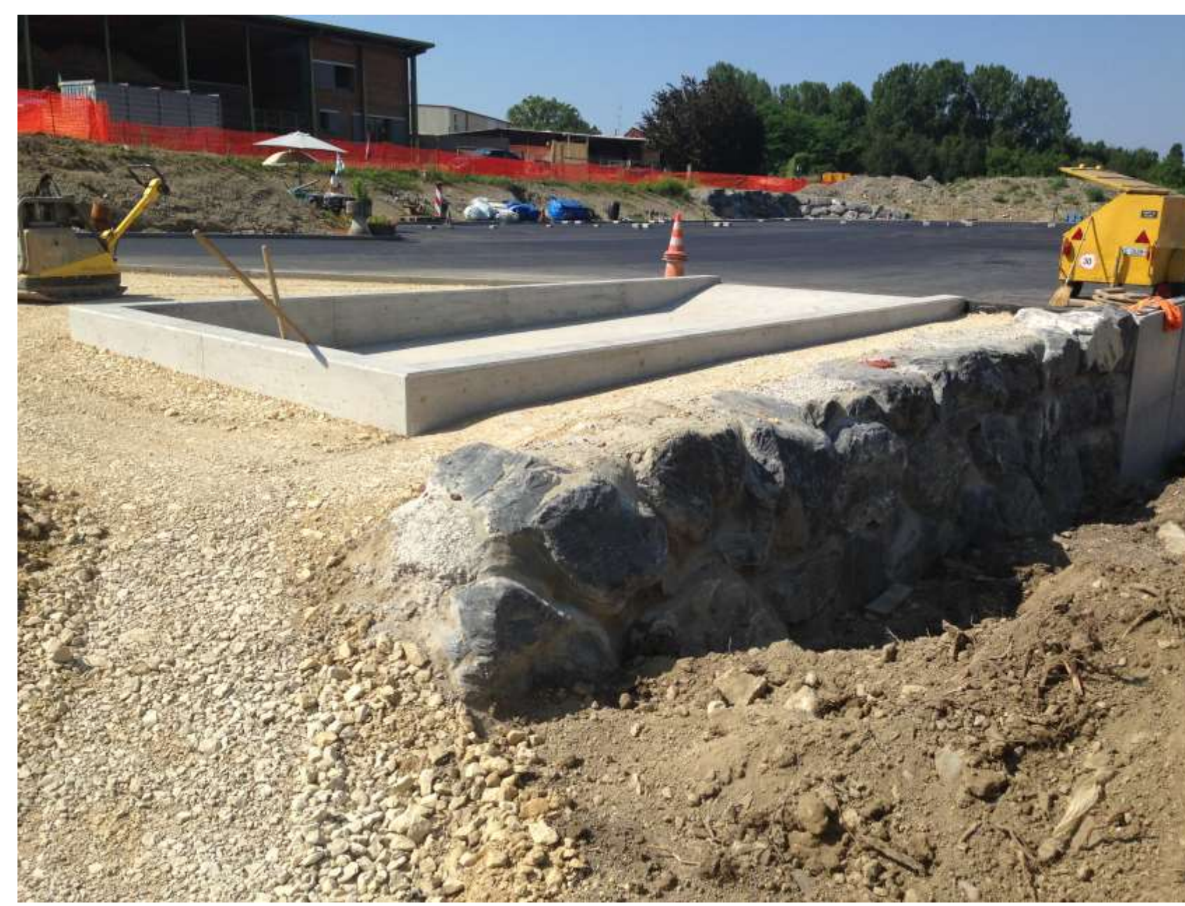
Construction d'un bac en béton pour la benne à balayures de route
