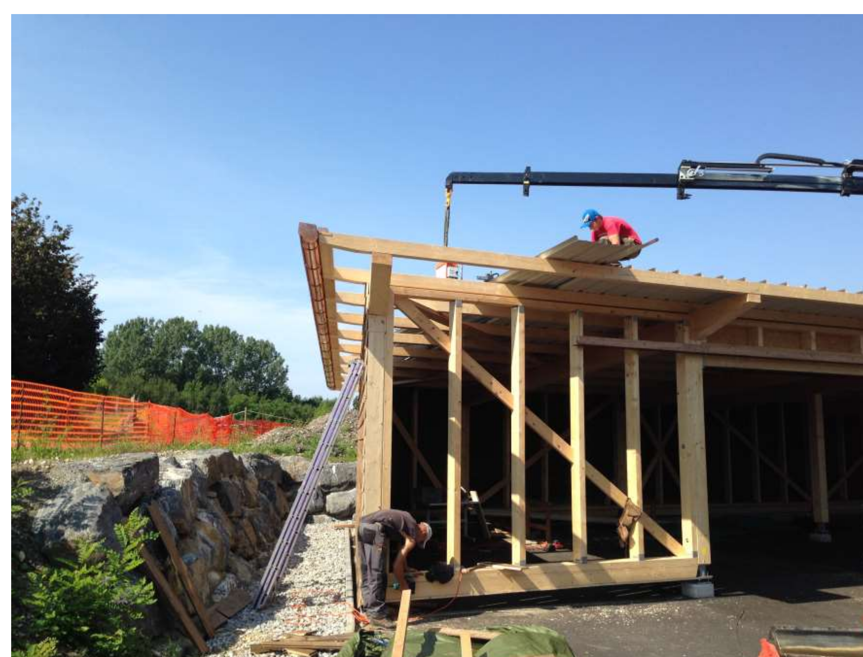
Les bâtiments construits en atelier, sont assemblés en quelques jours par le charpentier
