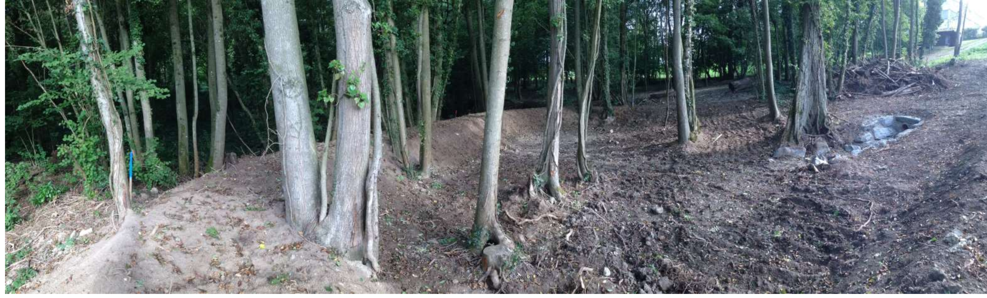
Une rétention des eaux pluviales à été aménagée dans la forêt, en aval du site.
