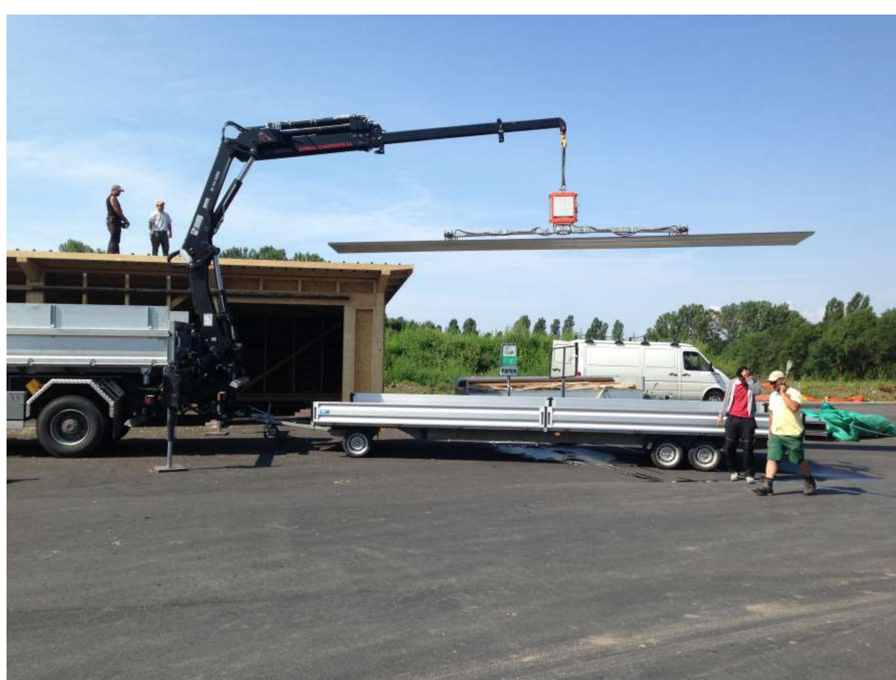
Les bâtiments construits en atelier, sont assemblés en quelques jours par le charpentier
