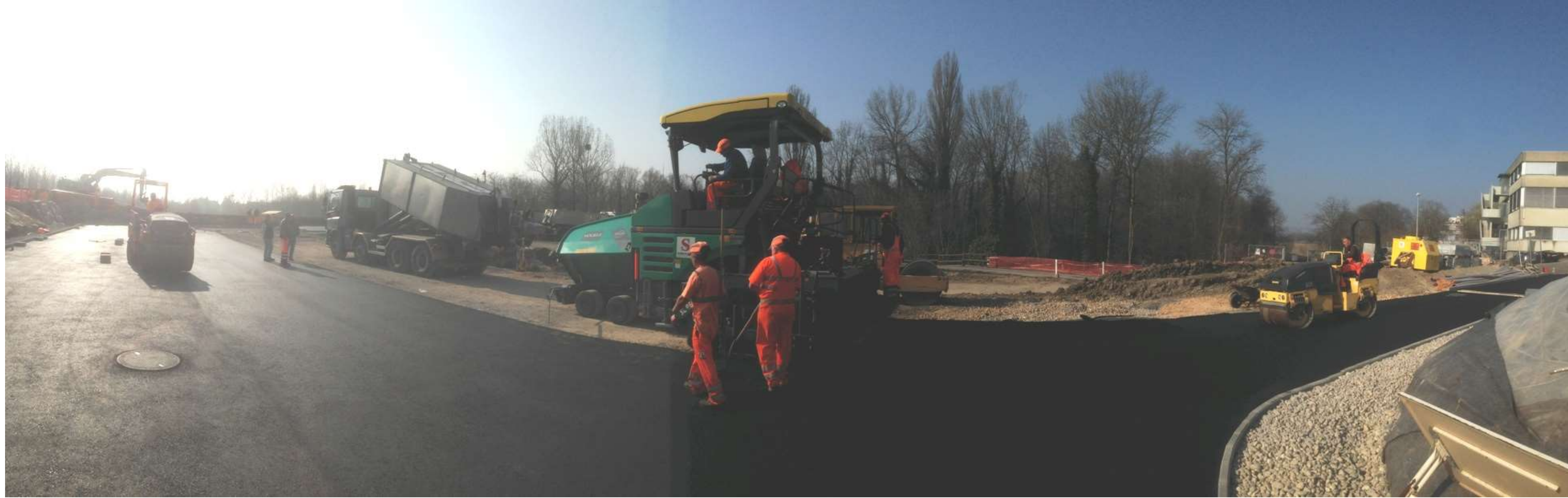
Pose des bétons bitumineux, ici la première couche de support. 5 étapes suivront, jusqu'au tapis définitif.
