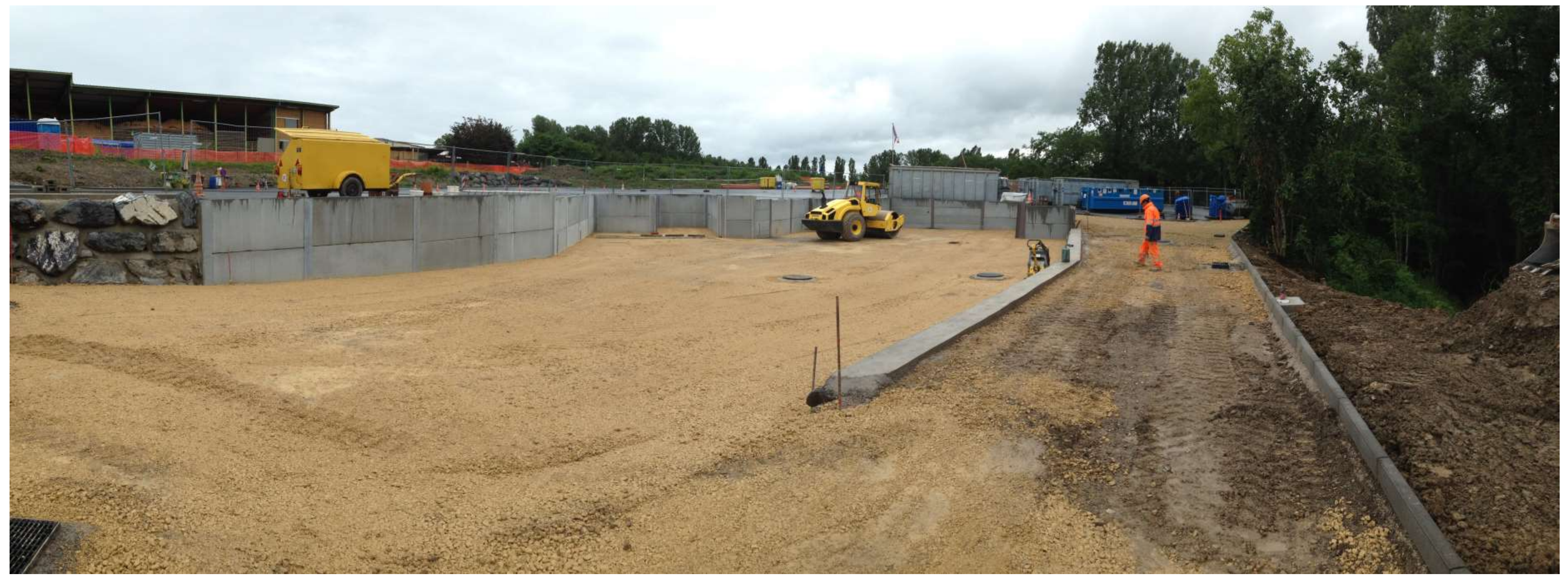
Les traverses de chemin de fer ont été remplacées par des panneaux en béton
