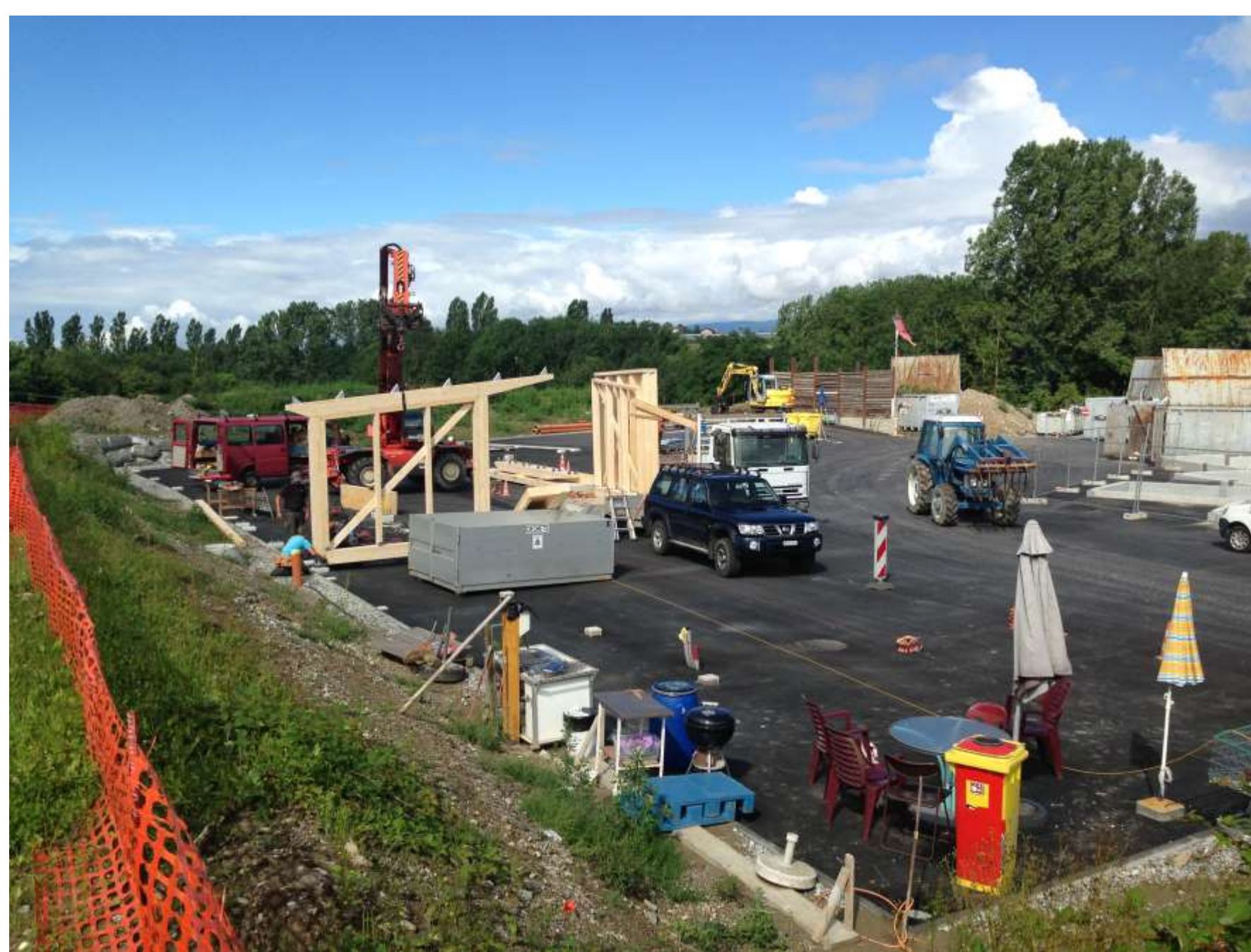
Les bâtiments construits en atelier, sont assemblés en quelques jours par le charpentier
