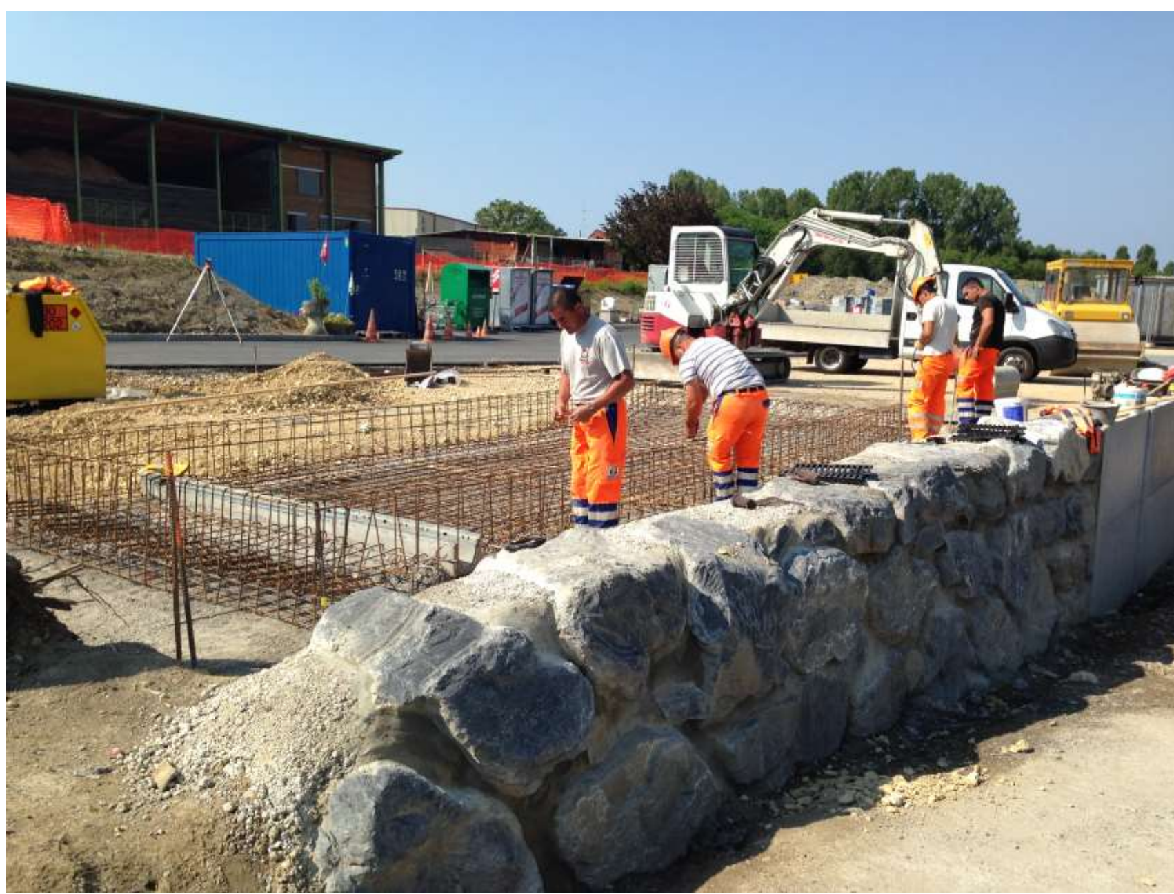
Construction d'un bac en béton pour la benne à balayures de route
