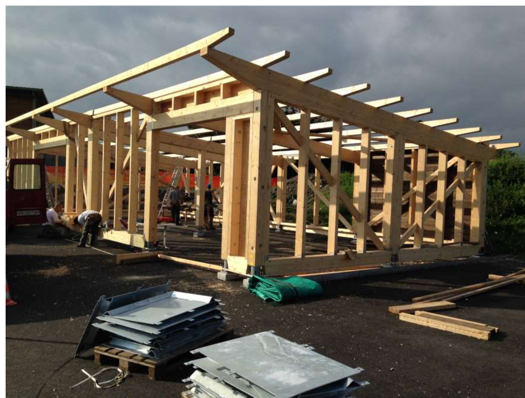
Les bâtiments construits en atelier, sont assemblés en quelques jours par le charpentier
