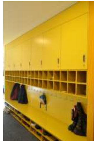
Réfection des menuiseries – Les Moufflets
