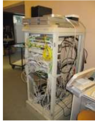
Armoire informatique avant travaux
