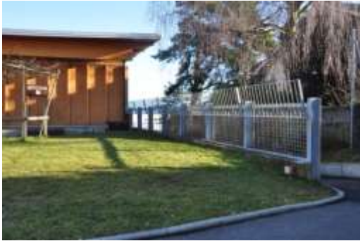
Nouvelles serrureries côté « réfectoire »
