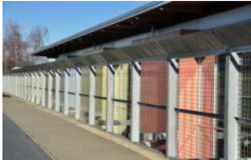
Nouvelles serrureries côté « préau »
