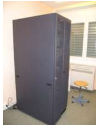
Armoire informatique après travaux
