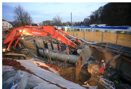
Déviation coll. 150 à la Mouline / entreprise Marti SA pour le PI sous TSOL / UNIL GEOPOLIS - SE-M+S 29.11.2011
