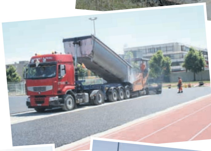
Pose de l'enrobé bitumeux
