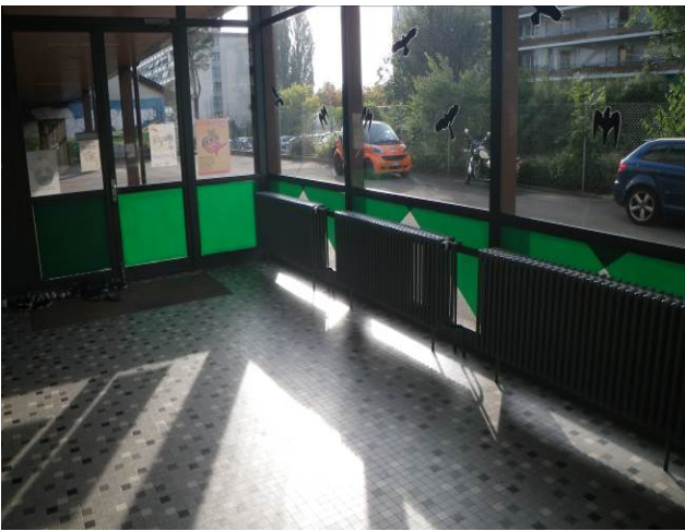
Le simple vitrage des parois vitrées des corridors implique un besoin de chauffage très important
