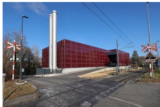
Centrale thermique/Data Center EPFL
