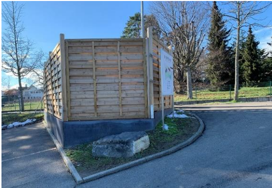
Enclos à containers
