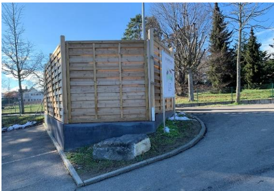
Enclos à containers
