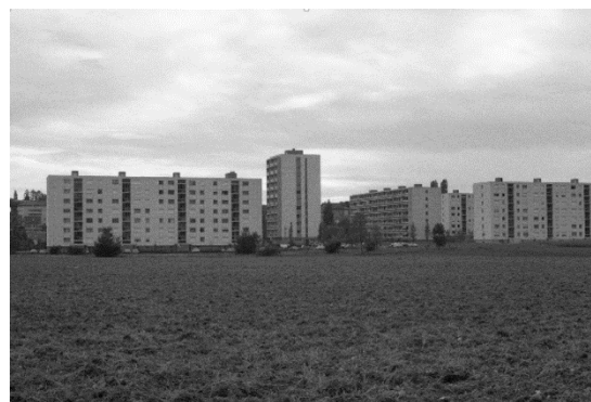
Ecublens, route du bois, 1974-1975 A gauche de la photographie: immeuble de la route du bois 19, 21, 23, 25. Pré devant l'immeuble: emplacement actuel du CSCE ©Archives communales d'Ecublens; Fonds S - 28 « 150 clichés du XX e siècle (1974-1975) ». Donateur: Jeanrichard (Olivier)
