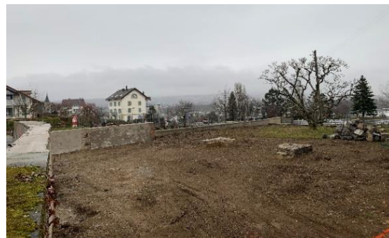
Terrain après démolition
