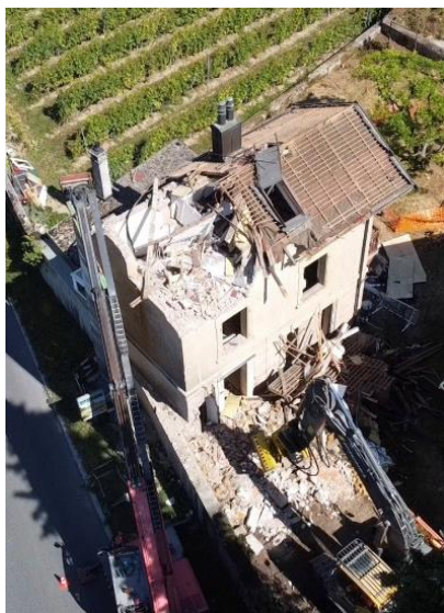
Vue aérienne des travaux de déconstruction
