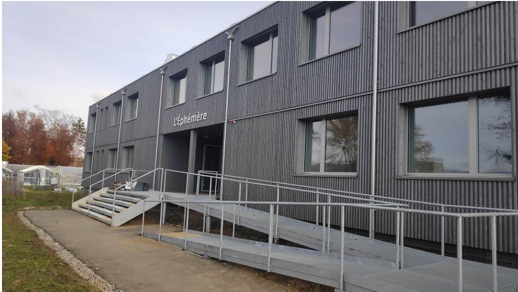
Bâtiment l'Ephémère UNIL – fin de travaux
