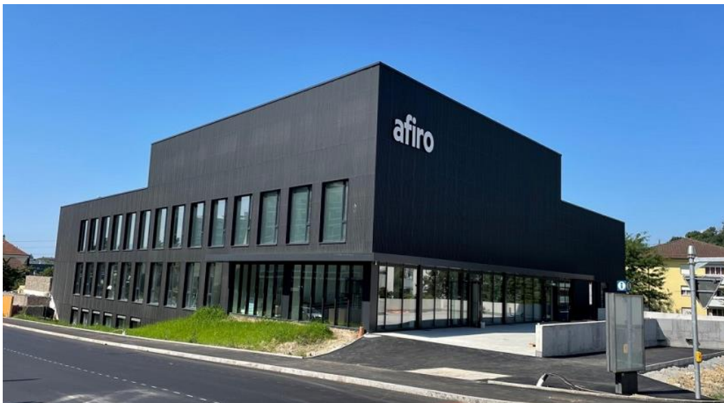
Bâtiment Afiro – fin de travaux
