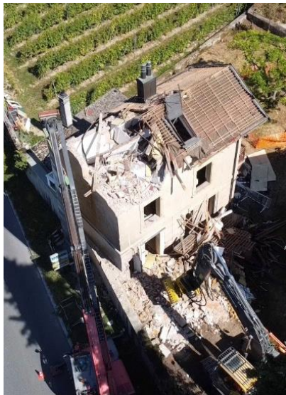
Vue aérienne des travaux de déconstruction
