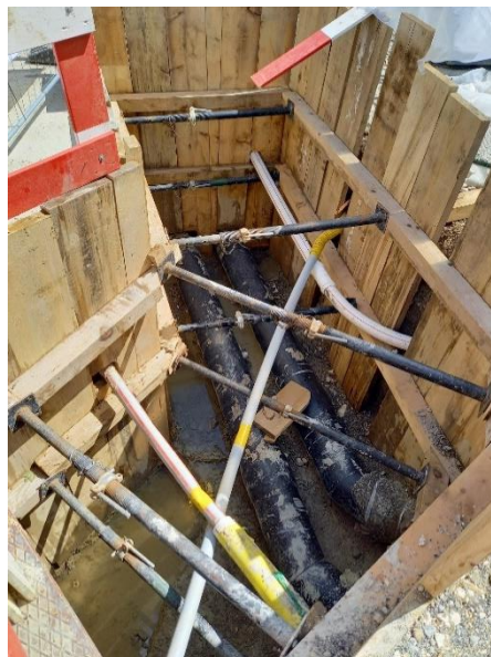
Pose des tuyaux de chauffage à distance dans une fouille
