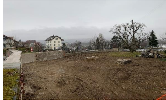
Terrain après démolition
