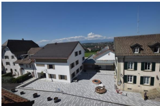
Auberge communale prise depuis la station photographique installée sur la Cure
