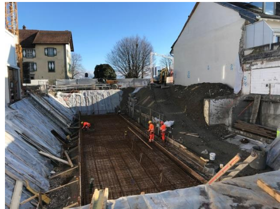
Travaux de ferrillage de la première moitié du radier
