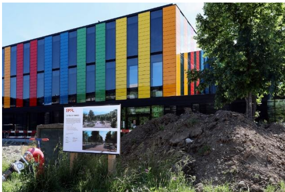
EPFL : intersection avenue Piccard et route des Noyerettes
