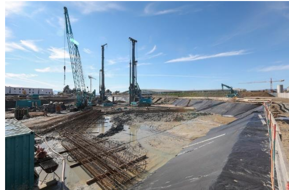
EPFL : chantier RTS
