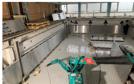
Travaux de pose du nouveau bassin inox
