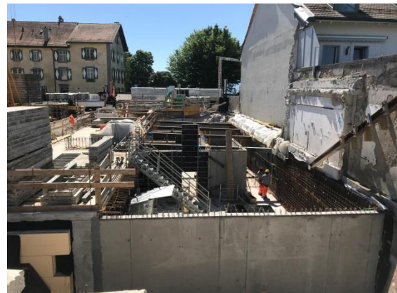
Préparation du coulage du dernier mur en béton armé du sous-sol
