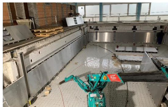
Travaux de pose du nouveau bassin inox
