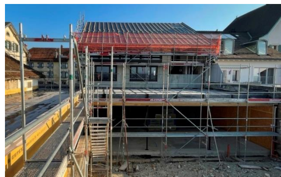
La charpente de la toiture à deux pans, les toitures de la salle à manger et de la cuisine sont posées
