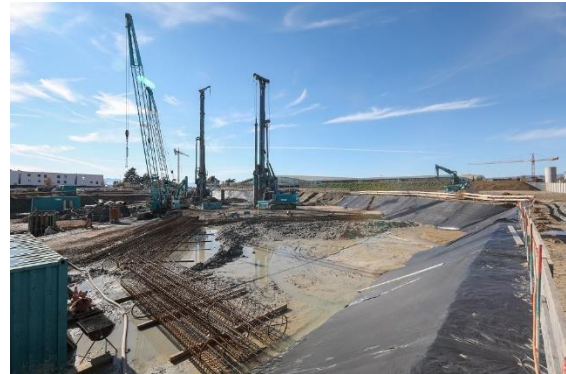
EPFL : chantier RTS
