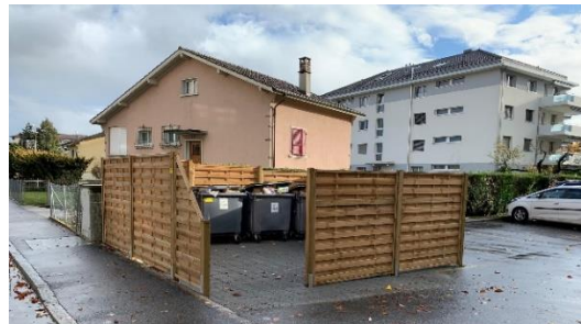
Nouvel enclos à containers
