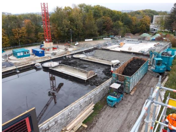
EPFL : centrale de chauffe
