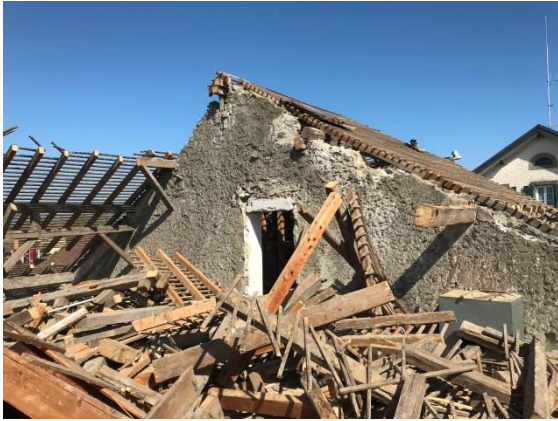
Déconstruction de la toiture avec tri des matériaux à la source
