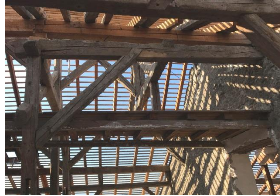
Photo de la charpente de l'ancienne Auberge
