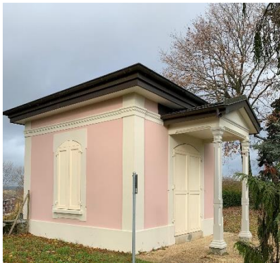
Réfection du Pavillon de Mon Repos
