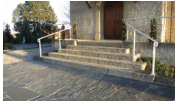
Pose d'une main courante sur l'escalier d'accès
