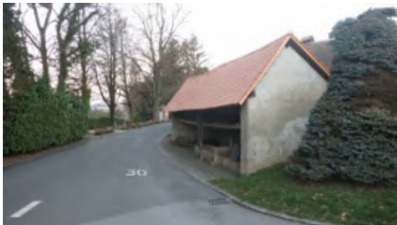
Rénovation de la toiture
