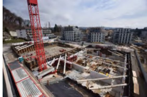
Exécution des murs de la salle de gymnastique mars 2018
