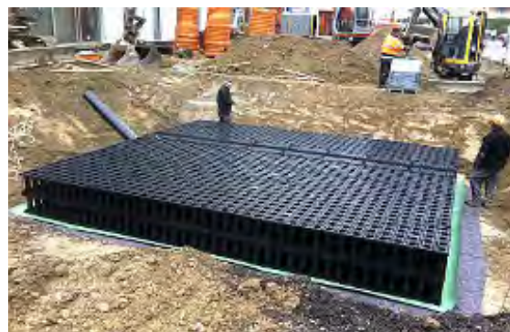
Pose d'un bassin de rétention / régulation des eaux claires – Quartier d'immeubles de Croset-Parc
