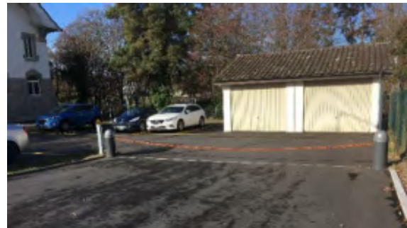
Nouveaux accès au parking – Barrière à chaîne
