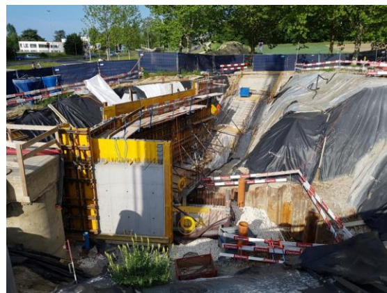
Construction d'un nouvel accès au passage inférieur sous la route Cantonale à l'UNIL
