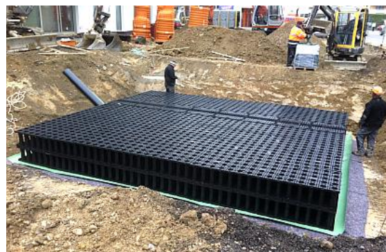
Pose d'un bassin de rétention / régulation des eaux claires – Quartier d'immeubles de Croset-Parc
