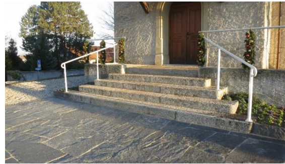
Pose d'une main courante sur l'escalier d'accès
