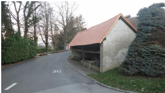
Rénovation de la toiture
