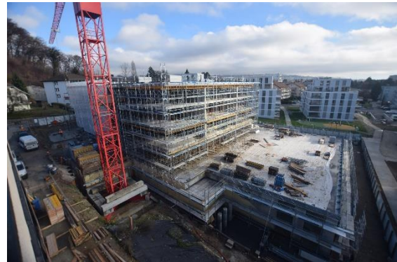
Fin du gros-œuvre et des travaux de maçonnerie décembre 2018
