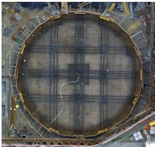
Vue en plan avant bétonnage du radier du silo sud-est
