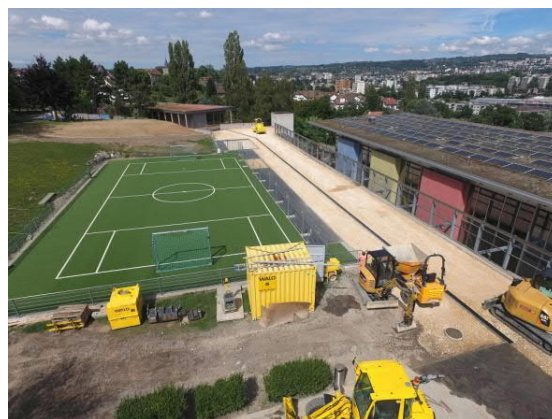
Chantier du réaménagement du chemin d'accès de la Coquerellaz
