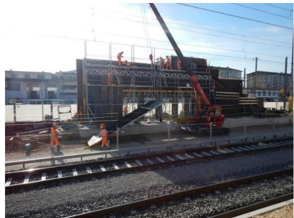
Gare de Renens – Piliers du futur Rayon Vert
