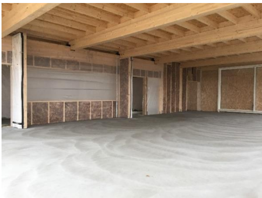
APEMS – Structure de la toiture terminée – Réfectoire – Décembre 2016
