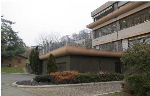
Crosset – Nouveau garde-corps – Muret de jardin
