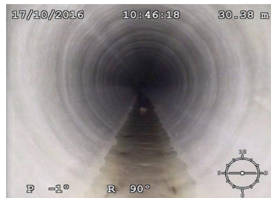
Collecteur après gainage
