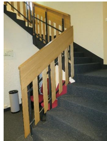
Hôtel de Ville – Rénovation de la cage d'escalier
