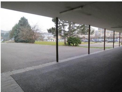
Saturne – Réfection de la cour de récréation
