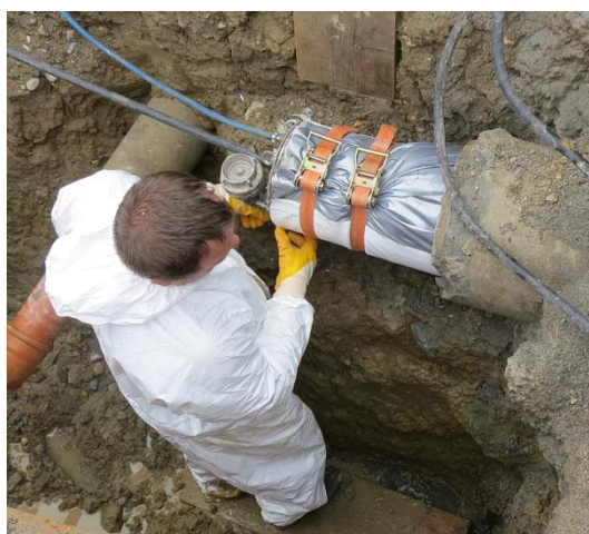
Durcissement de la gaine par polymérisation UV
