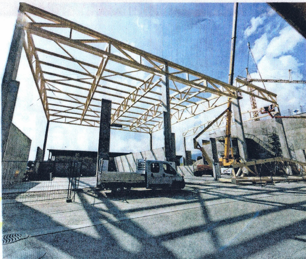
La «dernière pierre» de l'unité de tri et de recyclage des plastiques a été symboliquement posée hier sur le site de Cand-Landi à La Poissine. JEAN-PAUL GUINNARD
