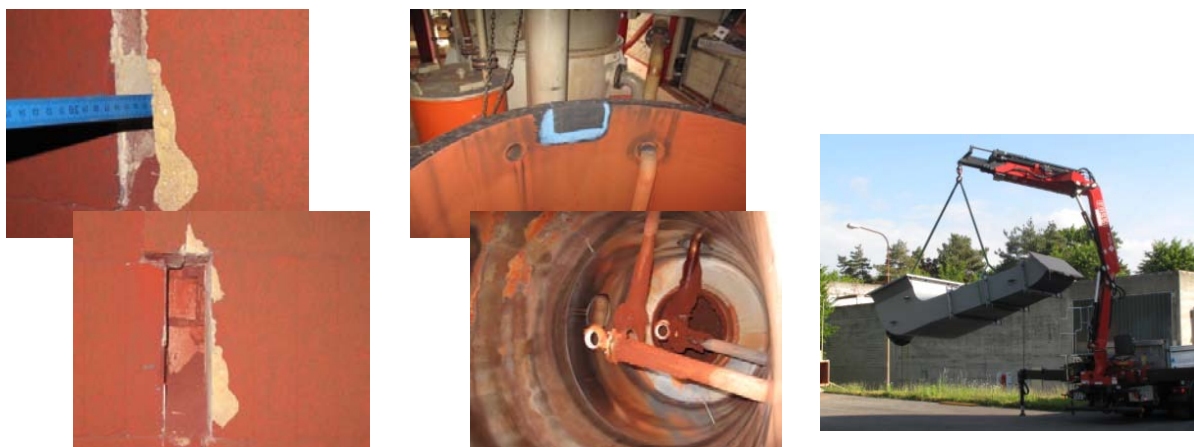
Maçonnerie, tour de lavage et gaine de fumées
