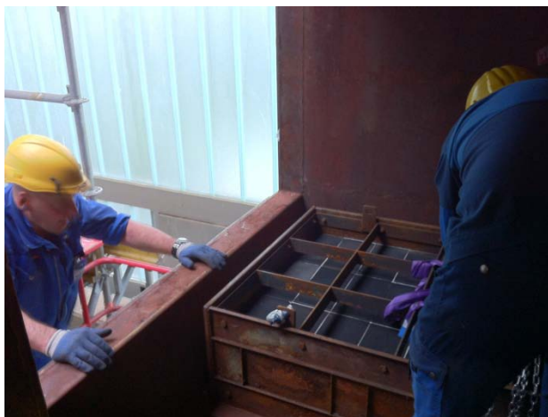
Mise en place du catalyseur CO
