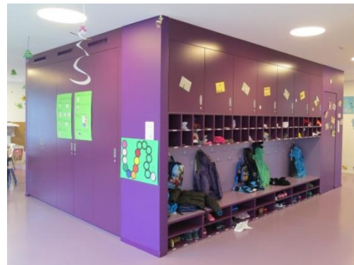
Réfection des menuiseries – UAPE Domino
