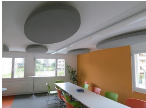
Panneaux acoustiques – Cafétéria CTC
