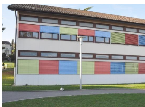
Nouveaux stores – Coquerellaz (SEMPA)
