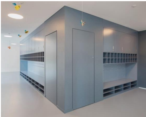
Réfection des menuiseries – Garderie Domino Photographe : Vincent Jendly
